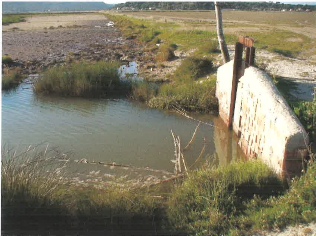
Detalle de la compuerta que controla la entrada de mareas en la zona de El Soto.
